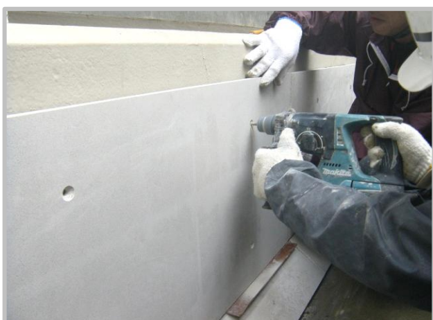
アンカー工 (削孔状況)
