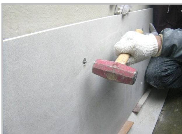
アンカー工 (打設状況)
