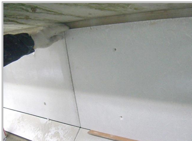
パネル設置工
