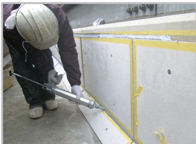
パネル目地工 (弾性シーリング材充填状況)
